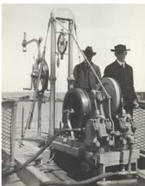
Rys.6. Sigsbee Sounding Machine na pokładzie statku U.S. Albatross (źródło: Sea and Sky Ocean Exploration Timeline)
