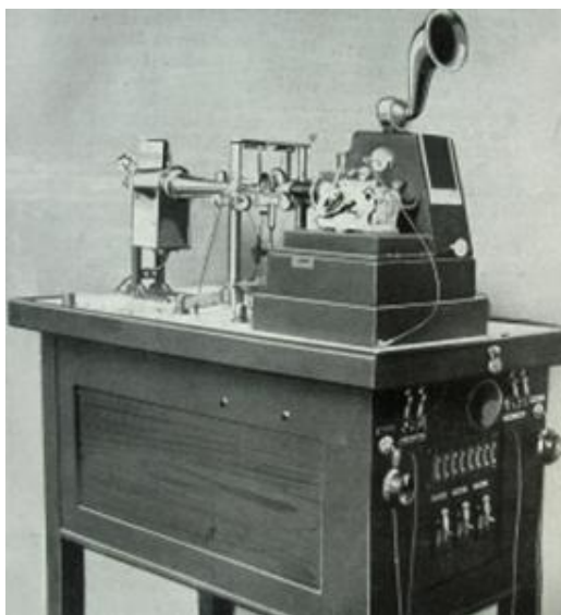
Ryc.8. Echo sonda Behm z katalogu firmy Behm-Echolot-Gesellschaft z 1918 r. (źródło: SH von A bis Z A. Behm)
